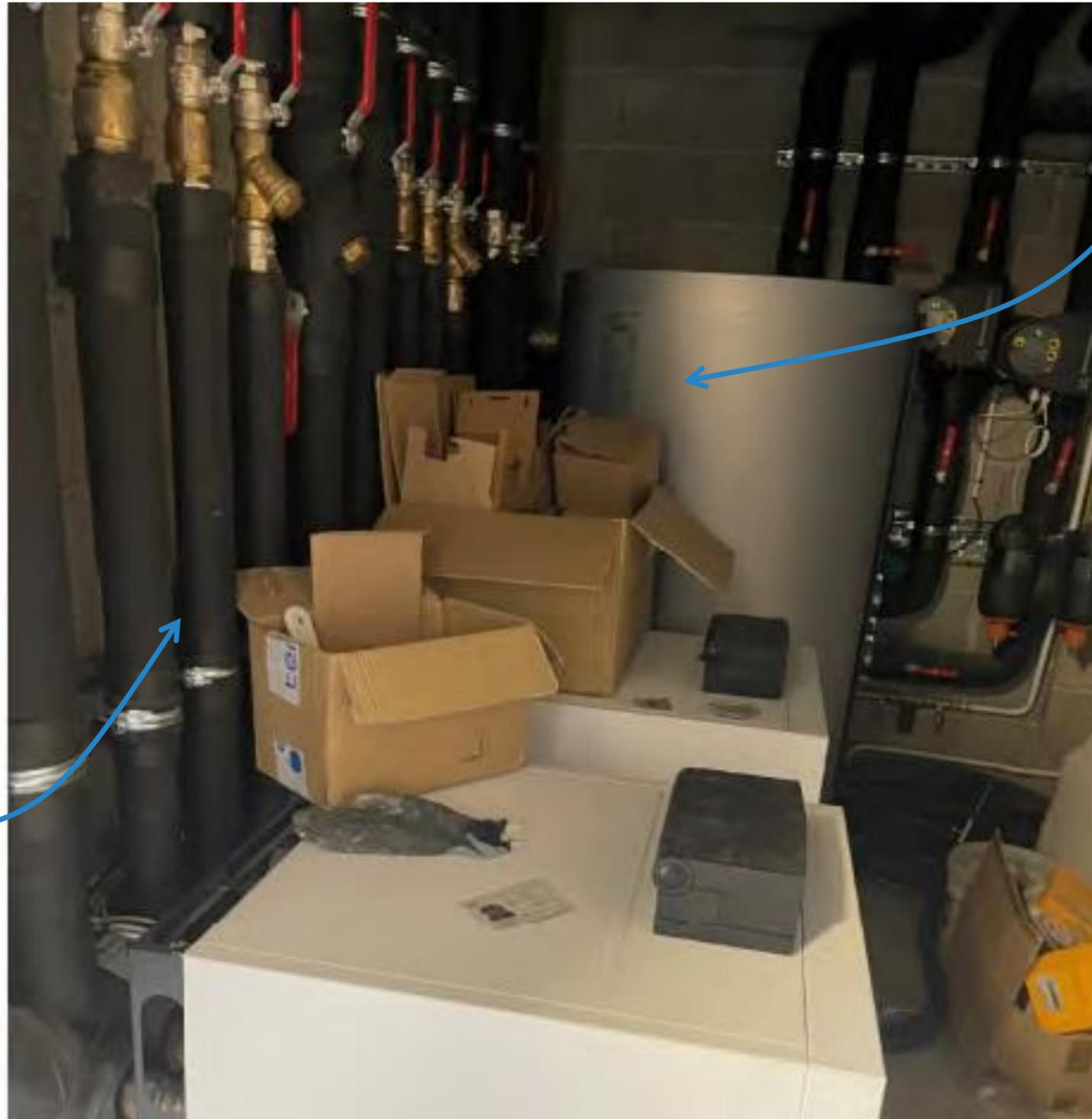
1 Ballon tampon chauffage : Viessmann Vitocell 100E-SVP 400L
