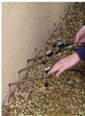
Injection de résine (Photo : dakdurieux.be)
