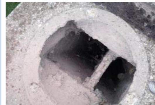
Ces conduits sont de type « maçonné », ils ne peuvent pas être ventilés en VMC Haute pression.
