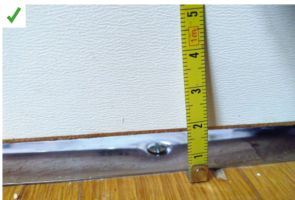
Le détalonnage de la porte de la cuisine est de 2 cm, conformément aux règles de l'art. ©AQC
