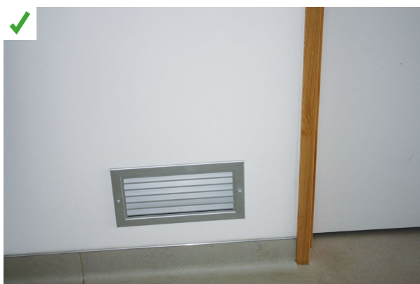
La grille de transfert présente dans la cloison permet de respecter le principe de balayage de l'air tout en assurant une atténuation acoustique... ©AQC
