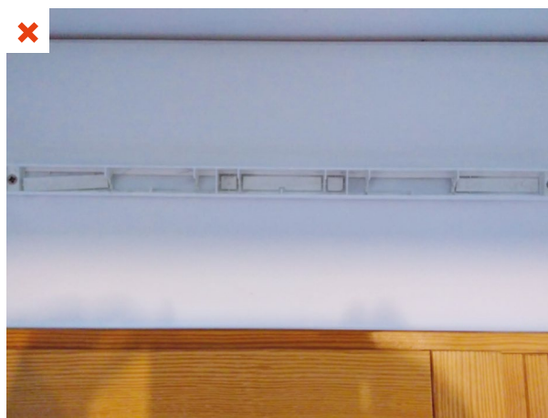
Sur ce coffre de volet roulant, une entrée d'air a été posée mais la mortaise n'a pas été réalisée. ©AQC
