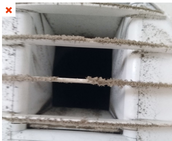
Cette bouche d'extraction de cuisine est encrassée. Aucun entretien n'est prévu. ©AQC
