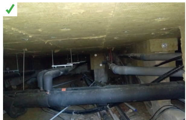
Une retombée d'isolant a été réalisée sur les refends de ce vide sanitaire. ©AQC
