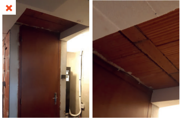
L'isolation du plancher haut du garage s'arrête au niveau de la zone de débattement de la porte d'accès à l'étage de la maison.
