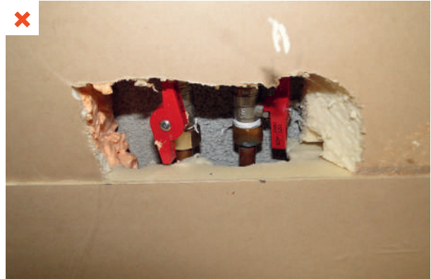
Le réseau d'eau sanitaire fixé au plafond du garage a été isolé par l'opération d'isolation de la dalle. La découpe de l'isolant pour conserver un accès aux vannes génère un important pont thermique. ©AQC
