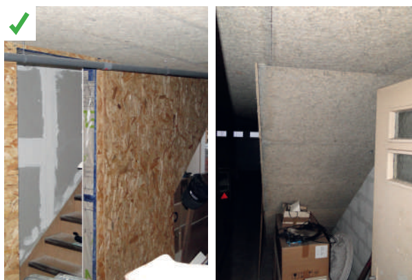
La cage d'escalier menant au garage a été entièrement isolée lors des travaux d'isolation du plancher bas. ©AQC
