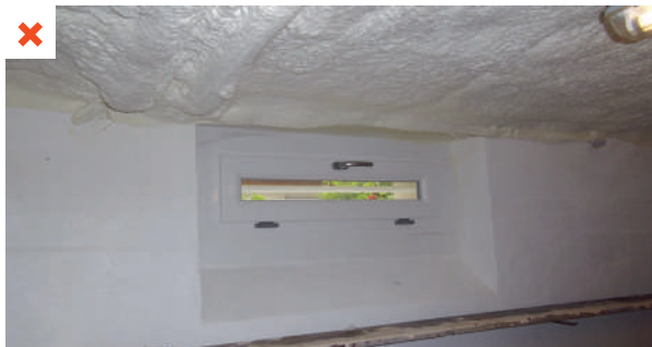
Dans cette cave semi-enterrée dont le plafond a été isolé, les soupiroux ont été remplacés par des fenêtres, empêchant de fait la ventilation naturelle lorsque celles-ci sont fermées. ©AQC
