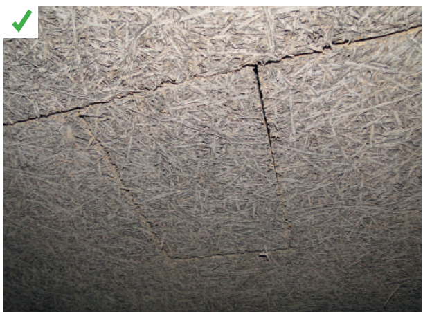
Un bouchon amovible découpé à façon a été réalisé pour permettre un accès à la vanne du réseau d'eau. ©AQC
