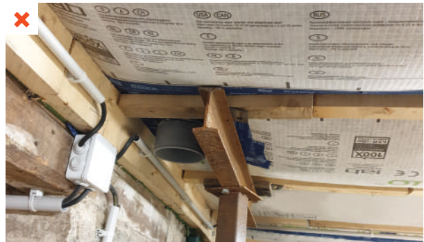
La membrane frein vapeur hydrovariable est positionnée du côté non chauffé de la paroi (isolation d'un plancher bois sur cave par insufflation de ouate de cellulose entre solives).
