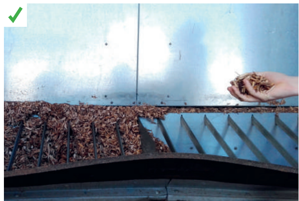
Contrôle visuel des plaquettes au moment de la livraison. Les barreaux métalliques sur le silo de dépotage facilitent le contrôle visuel. ©AQC
