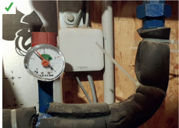
La présence d'un manomètre permet de vérifier la pression du réseau hydraulique et l'absence de fuites, notamment avant le changement de la chaudière. ©AQC
