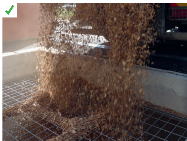
La présence d'une grille sur le silo de dépotage facilite le contrôle visuel et permet de retenir les plus grosses pierres. ©AQC
