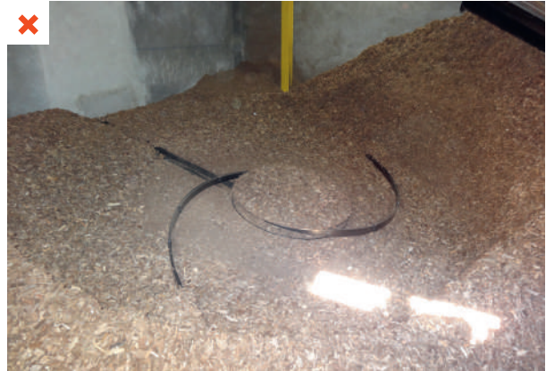
En fin de saison, le silo n'a pas été vidé et la maintenance du silo et du dessileur est rendue difficile. ©AQC
