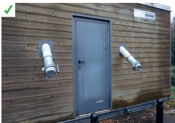
Silo alimenté par soufflage évitant l'installation de vis sans fin. ©AQC
