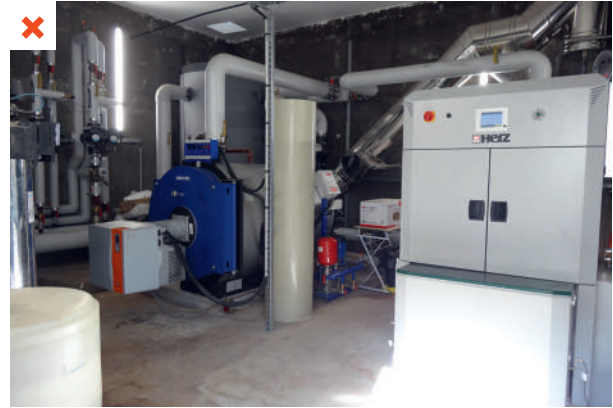
La chaudière d'appoint au gaz à gauche a une consommation plus élevée que celle prévue en conception. ©AQC
