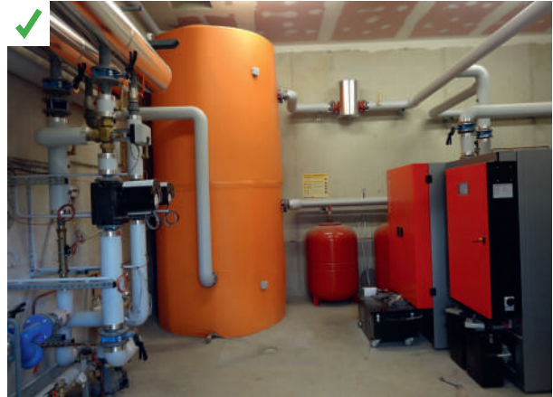
Pour limiter les courts cycles et les temps de fonctionnement en deçà de la puissance nominale, un ballon tampon a été installé.
