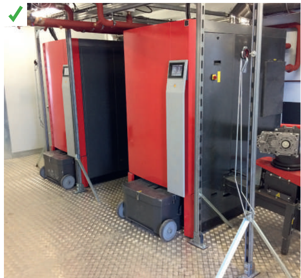
Pour la production de chauffage et d'eau chaude sanitaire de cet hôtel, une installation monoénergie a été mise en œuvre. Deux chaudières d'une puissance maximale équivalente ont été installées. Cette répartition des puissances a été dictée par la forte demande en eau chaude sanitaire tout au long de l'année.
