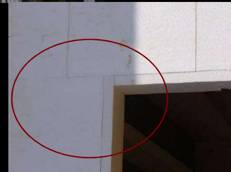
Fissuration à venir dans les angles, : joints des plaques, coïncident avec les irrégularités du support
