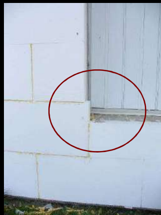
Fissuration à venir dans les angles, : joints des plaques, coïncident avec les irrégularités du support
