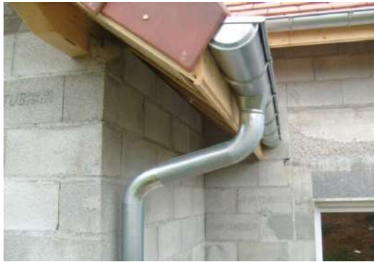
← Les descentes d'eau pluviales
