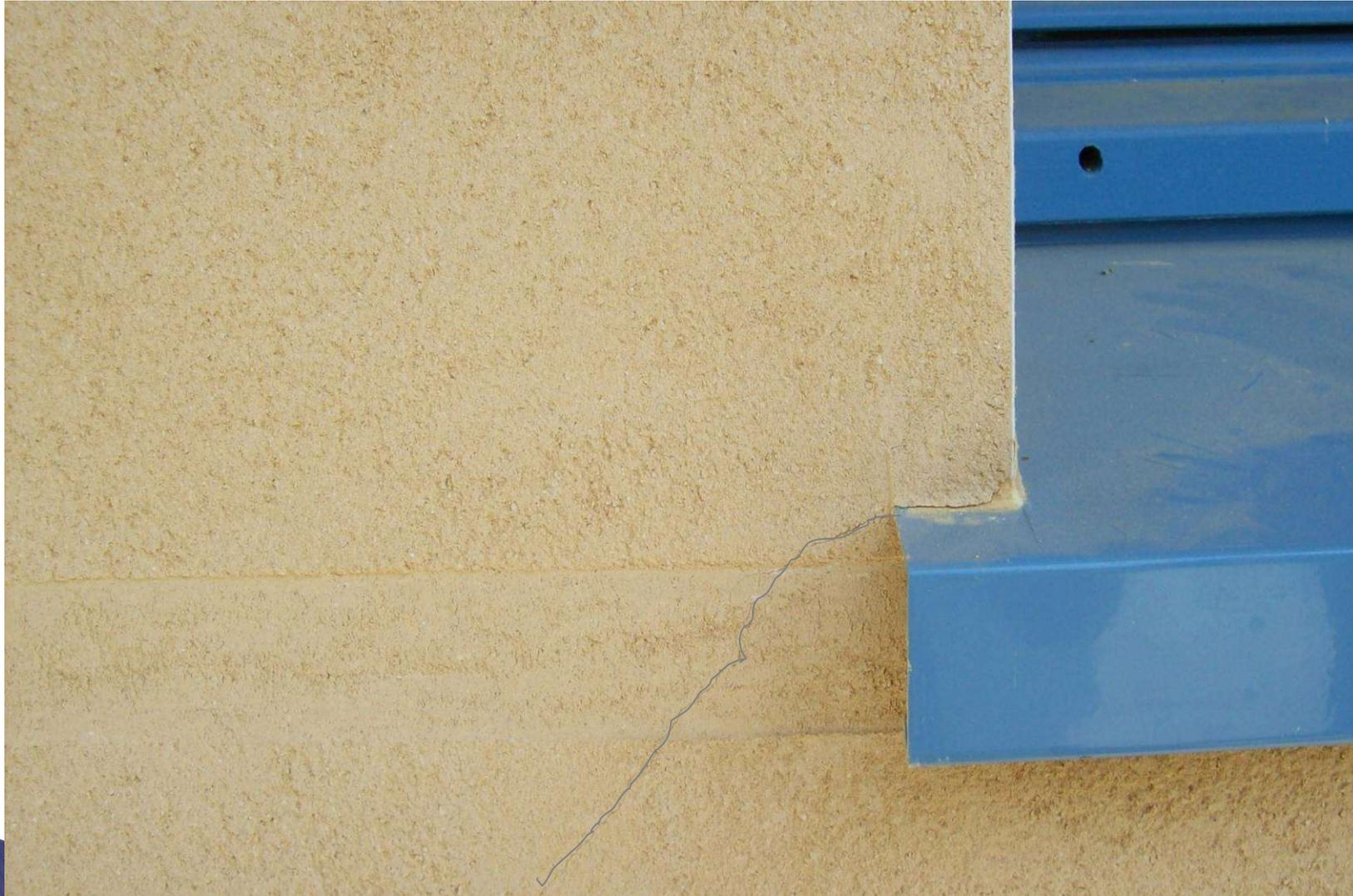
**Appui de fenêtre non-conforme**
