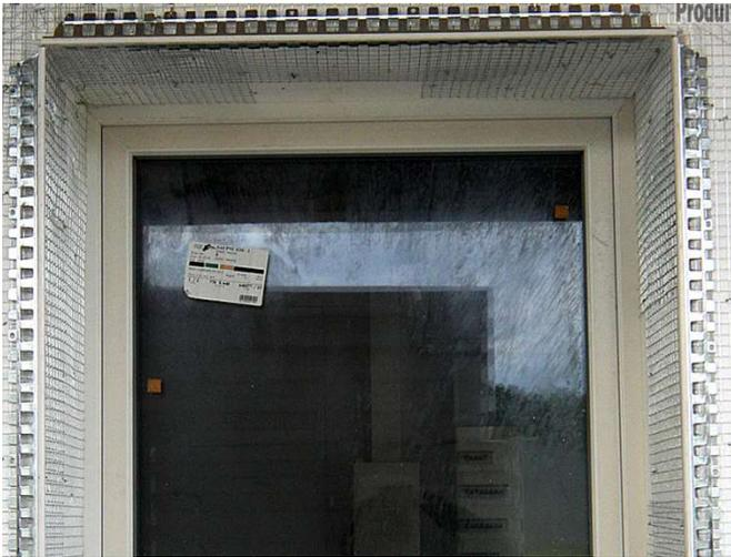
Dans le cas d'un enduit sur isolant en queue d'aronde, les cornières d'angles se posent après le treillis.
