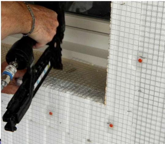
Les lès du treillis métallique, seront maintenus en partie haute par la rangée de chevilles de fixation des plaques et, déroulés vers le bas avec un recouvrement des lès de 10 cm, puis maintenus sur la surface de l'isolant avec des agrafes ou cavaliers.
