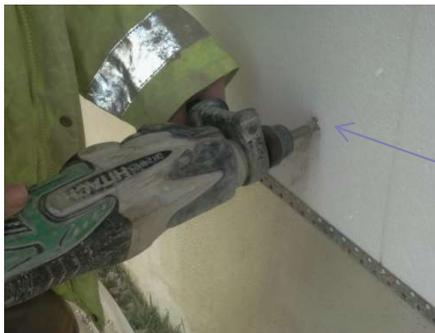
Perçage de l'isolant/support
