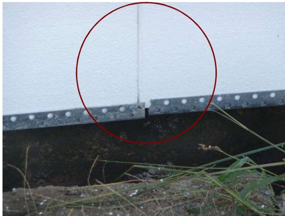
Les joints entre panneaux doivent être décalés d'au moins 0,1 m de la jonction entre deux profils de départ ou profils latéraux
