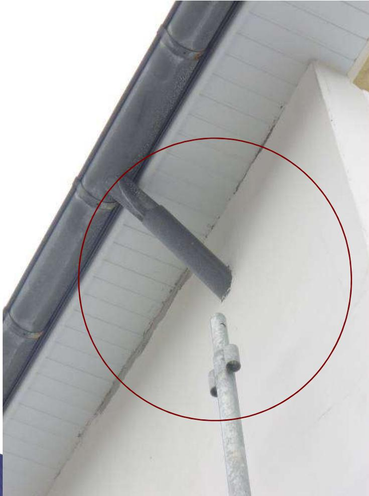
Descente d'eau pluviale encastrée dans l'isolant.
