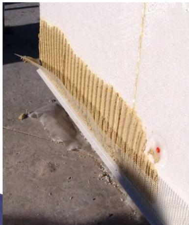
Dans le cas d'un enduit sur isolant lisse, les cornières d'angles se posent avant la fibre de verre.
