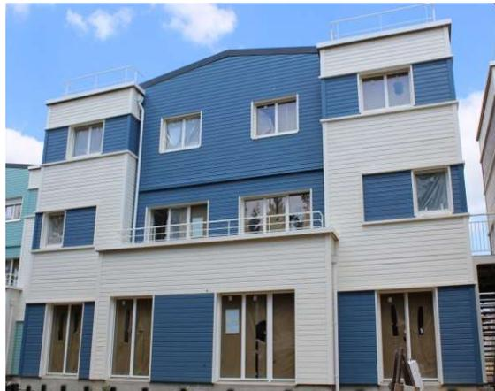
Système constitué d'un isolant, d'une structure porteuse faisant lame d'air et d'un parement assurant la protection de l'isolant et l'esthétique de l'ouvrage.
