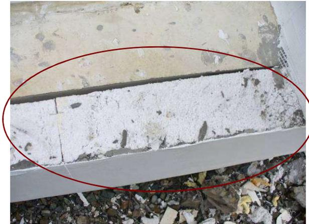
Absence de retour de l'armature sur l'appuis de fenêtre, aucune protection
