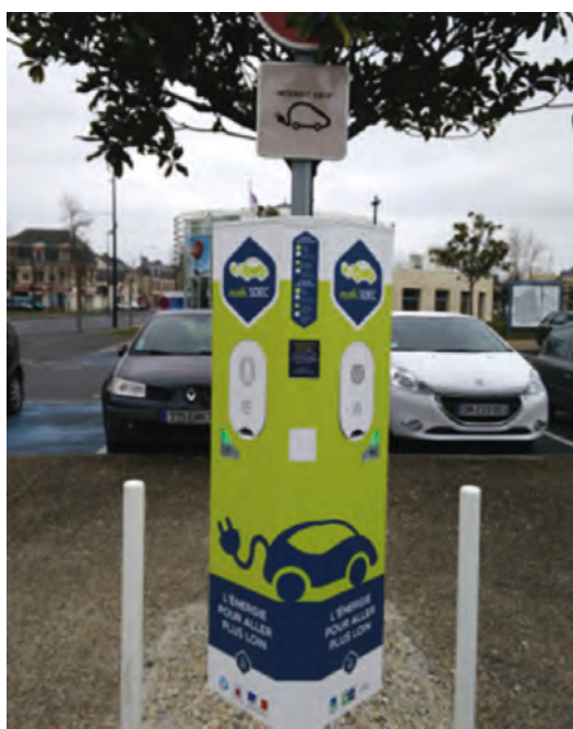
Point de charge directement raccordé au réseau public de distribution (RPD).
